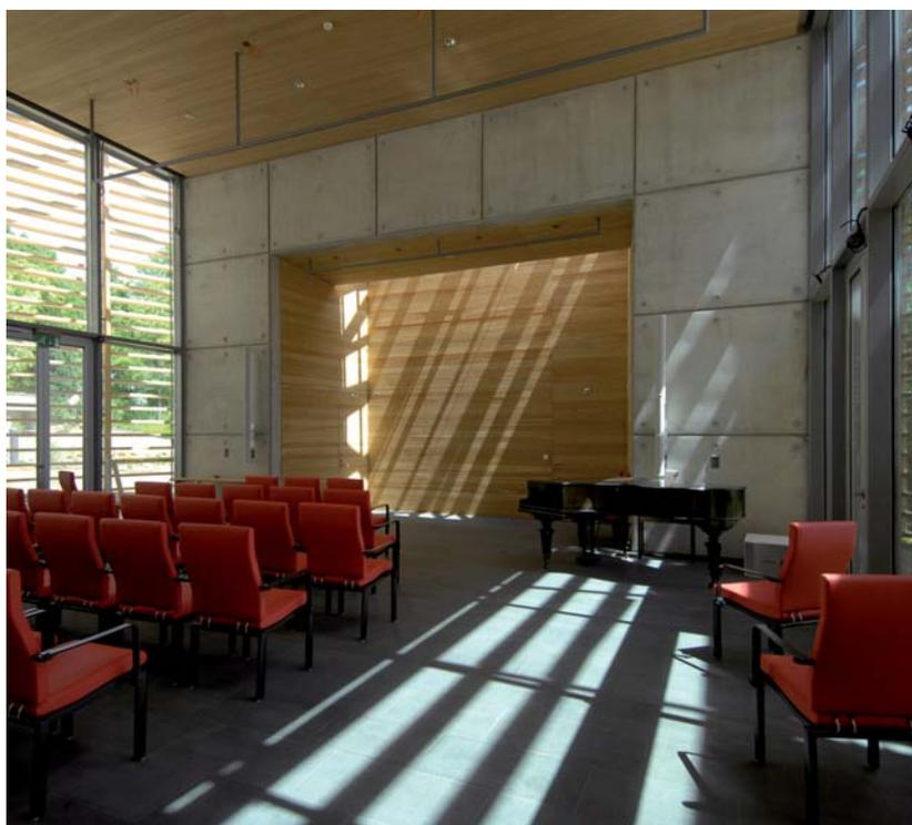
Les murs extérieurs sont revêtus d'une isolation crépie et les dalles de toiture sont protégées par une étanchéité et une isolation inversée. Des vitrages isolants sur structure métallique de type poteau traverse, équipés de stores, complètent l'enveloppe et permettent de contrôler la lumière selon le type d'activité dans la salle polyvalente.
